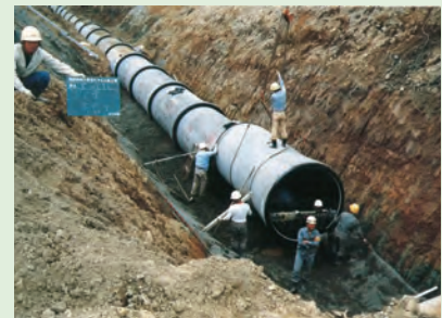
西部幹線水路（工事の様子）
